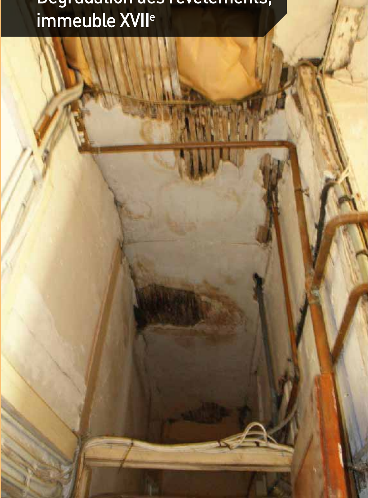
Dégradation du pan de bois et de l'hourdis de remplissage, immeuble XVI e
