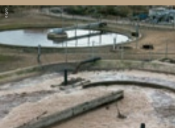
Un bassin de clarification, dans une station d'épuration
