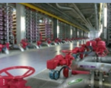
La salle de nanofiltration : une étape du procédé de potabilisation de l'usine de Méry-sur-Oise
